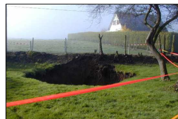
Mouvement de terrain (cavités souterraines)
